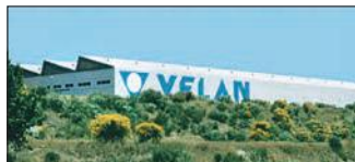
Lisbon, Portugal Velan Válvulas Industriais, Lda.
