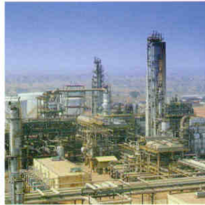
石油裂化管 Cracking tube (P-11右)
